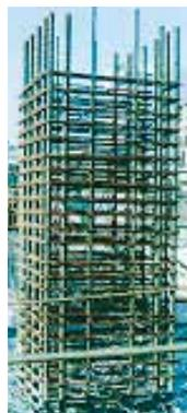
■ リバーボン785溶接閉鎖形を柱に使用した配筋例
