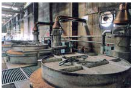
〔自動制御なまし炉〕
