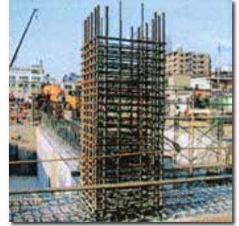
〔溶接閉鎖形を柱に仕様した配筋例〕
