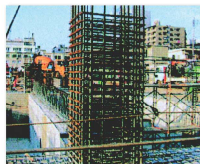
[溶接閉鎖形を柱に仕様した配筋例]
